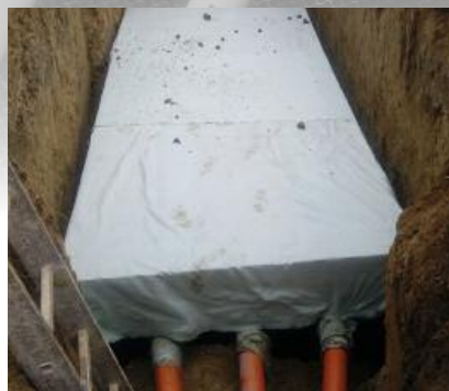
Ugradnja upojnih bioboxeva / Installation of absorption biobox
