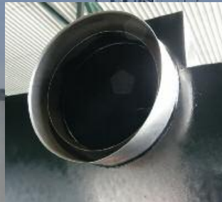
ULAZNA CIJEV SEPARATORA SEPARATOR INLET PIPE
