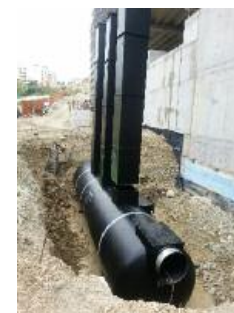
Prikaz ugradnje specijalnih separatora na terenu / Installation of a special separator on site
